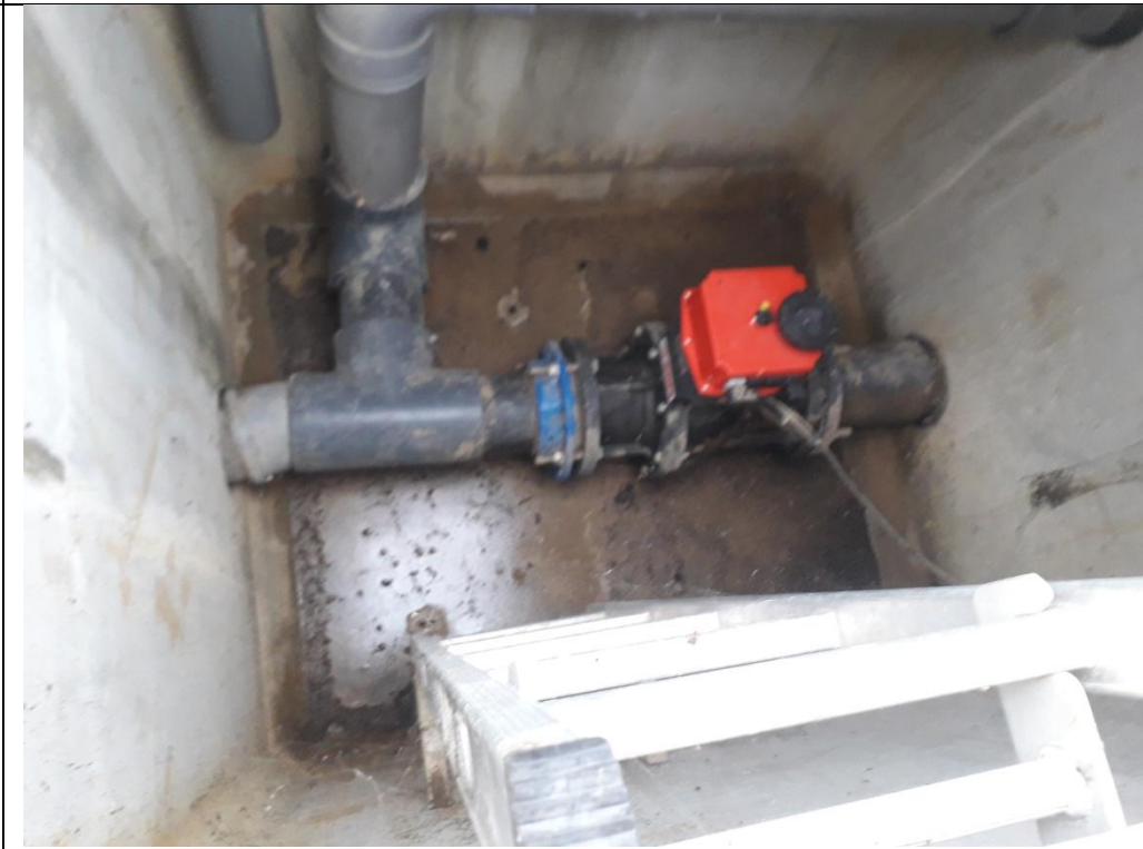
Vanne électromécanique et trop plein de la second chasse
