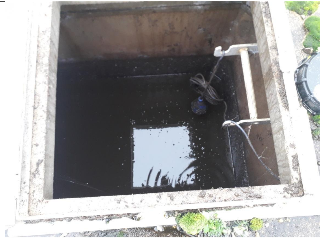
Poire de déclenchement du second étage
