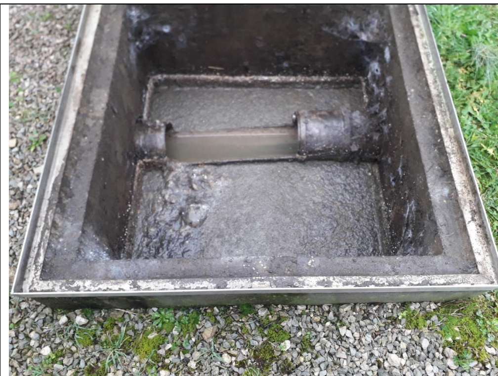
Regard B : trop plein avec décantation (1 m de hauteur)
