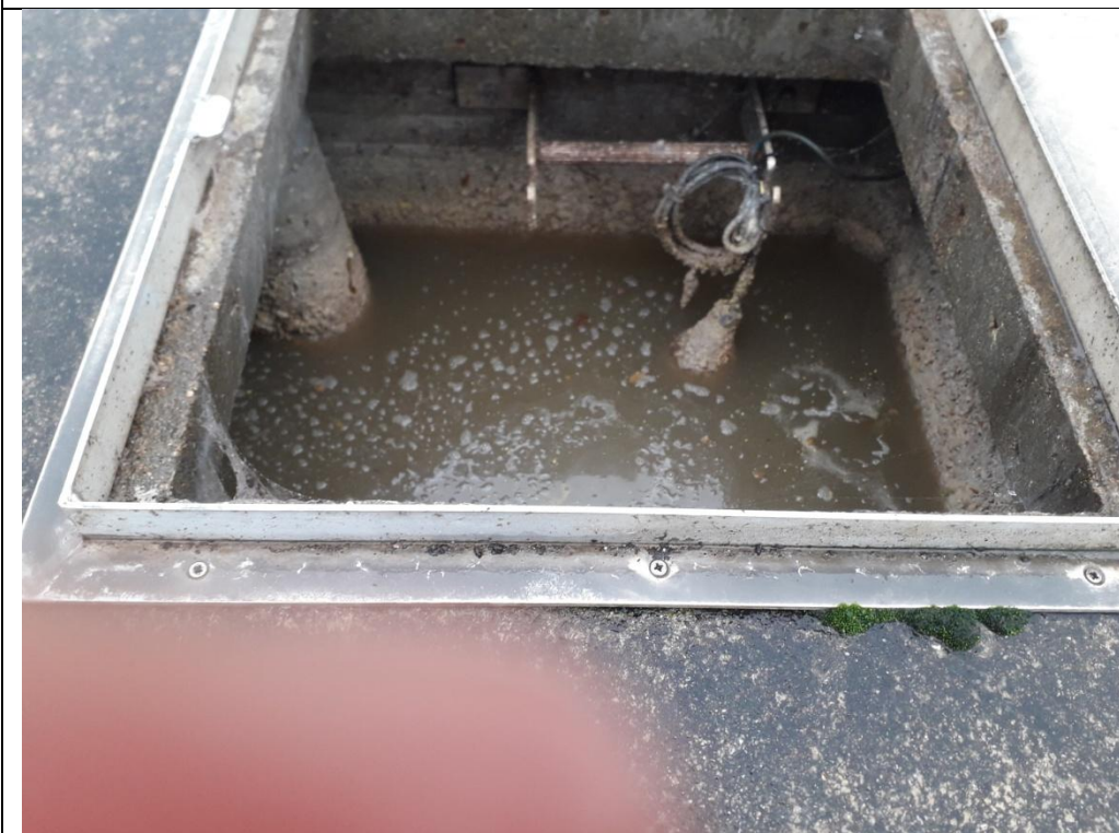
Second regard constituant la chasse avec poire de déclenchement et trop plein
