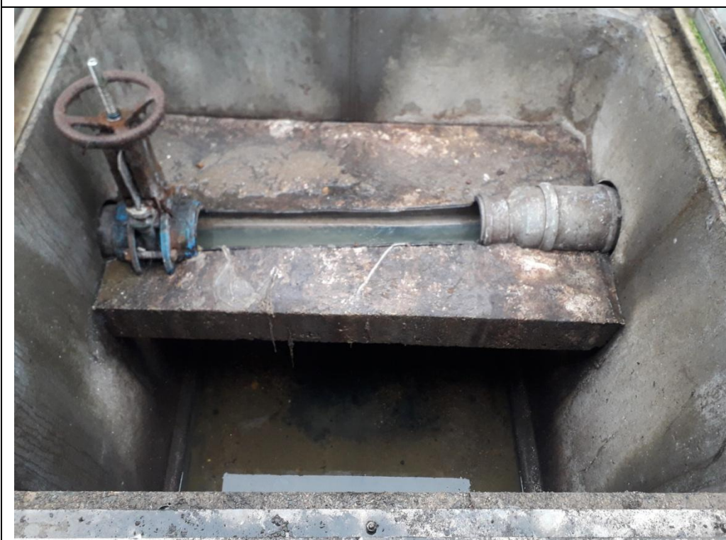
Regard C : Trop plein avant dégrilleur – Vanne d'isolation corrodée
