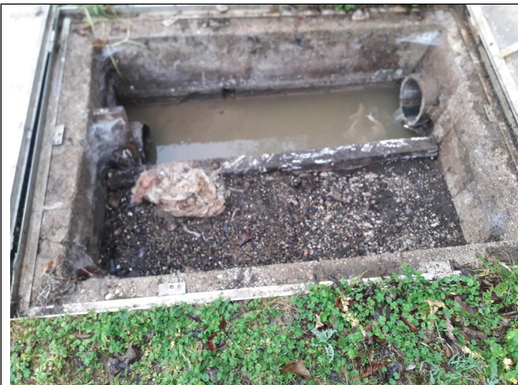
Dessableur – jonction canalisation grès – réseau PVC posé pour la nouvelle STEU (A sur plan))
