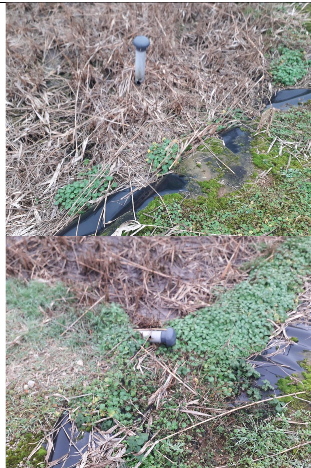
Photos d'aération à réparer – casses liées au faucardage
