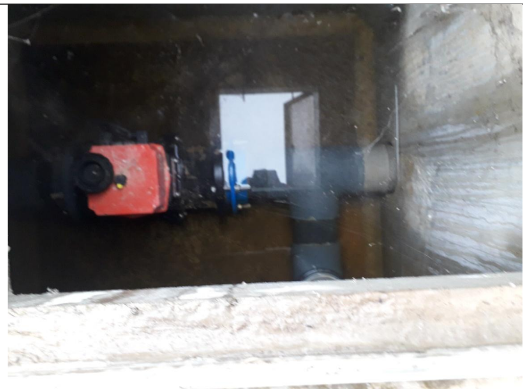
Vanne d'alimentation des filtres avec trop plein sur la droite
