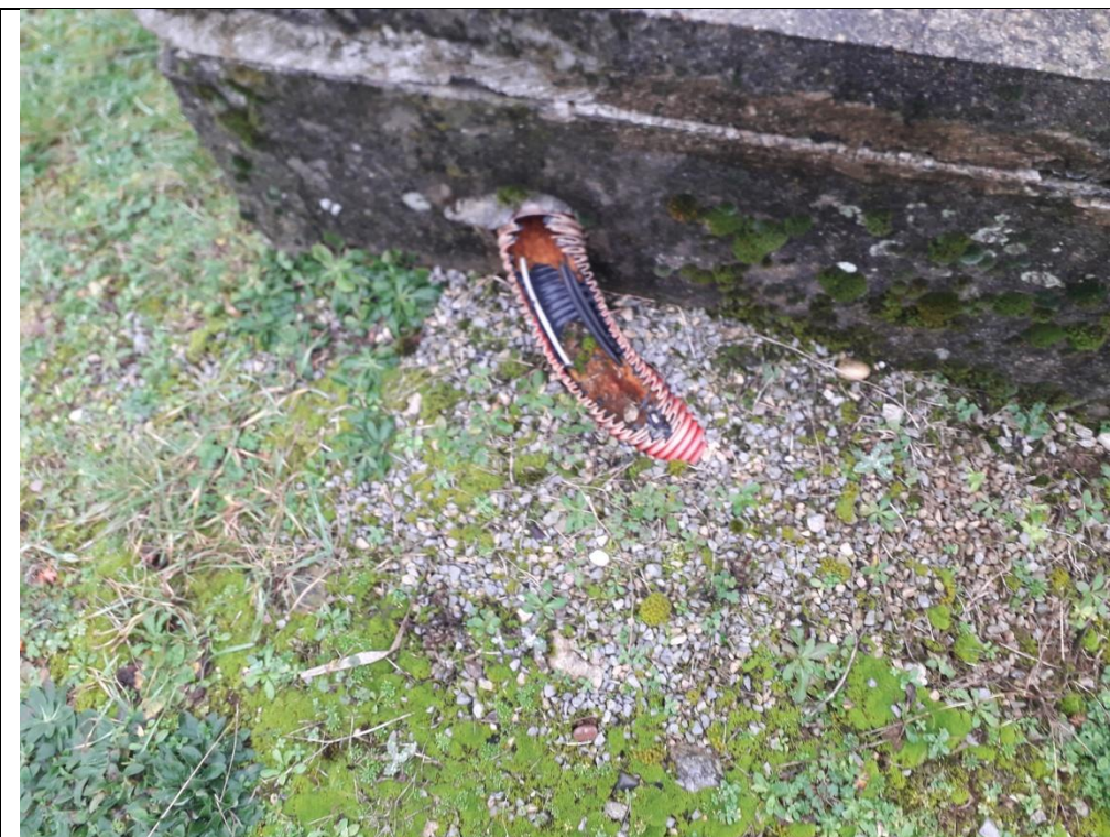
Gaine TPC et câbles électriques et de communication non protégés
